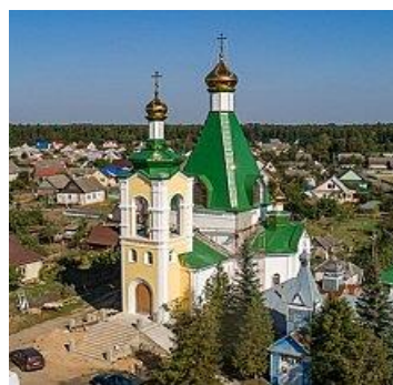
Фото 2. Строящаяся церковь в г. Старые Дороги
